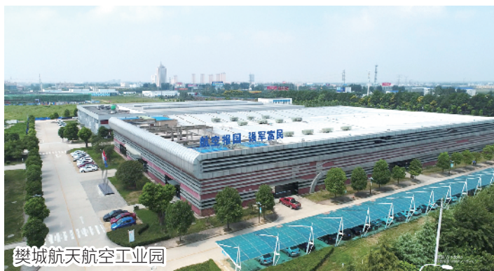
中通快递鄂西北分拣结算中心项目
